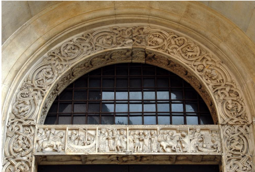
Figure 3. Lintel, Porta dei Principi. Modena, Cattedrale Metropolitana di Santa Maria Assunta e San Geminiano, c. 1106-1120. Photograph by author, 2017.
